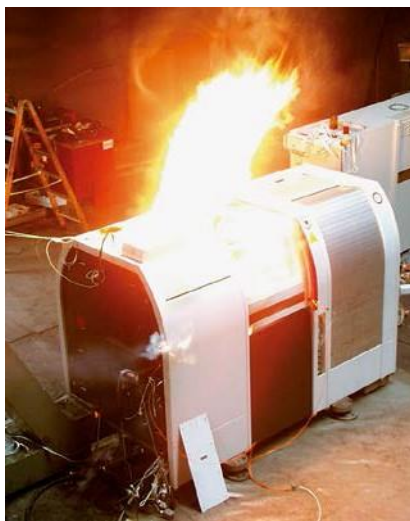
Figura 43 Ejeção de chamas de uma válvula de alívio da pressão
