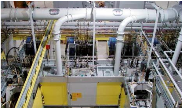
Figura 38 Furos de inspeção
