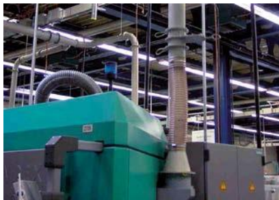
Figura 37 Peça de conexão para isolamento da vibração: vertical, aterrada
