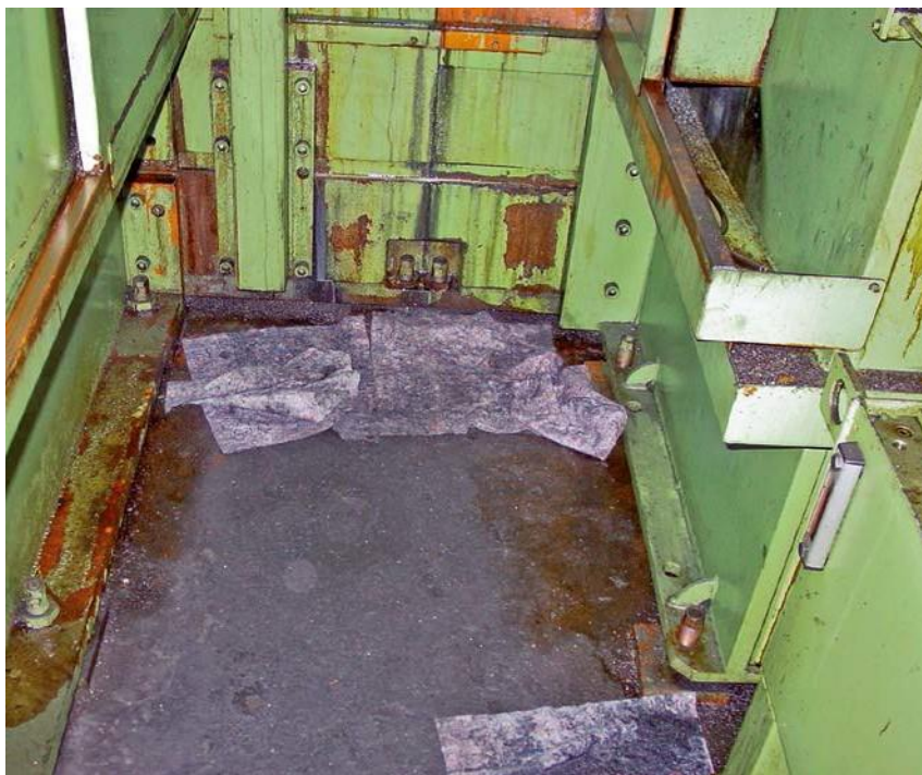
Figura 57 Risco de incêndio próximo de uma máquina
